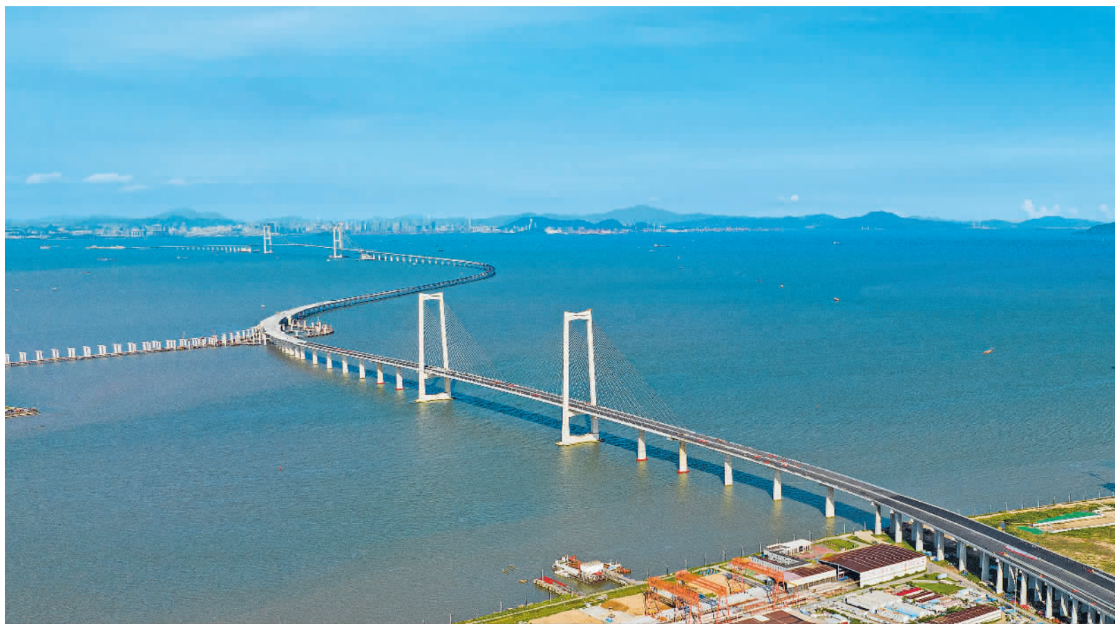
11月28日,粤港澳大湾区超级工程深中通道主线正式贯通。
