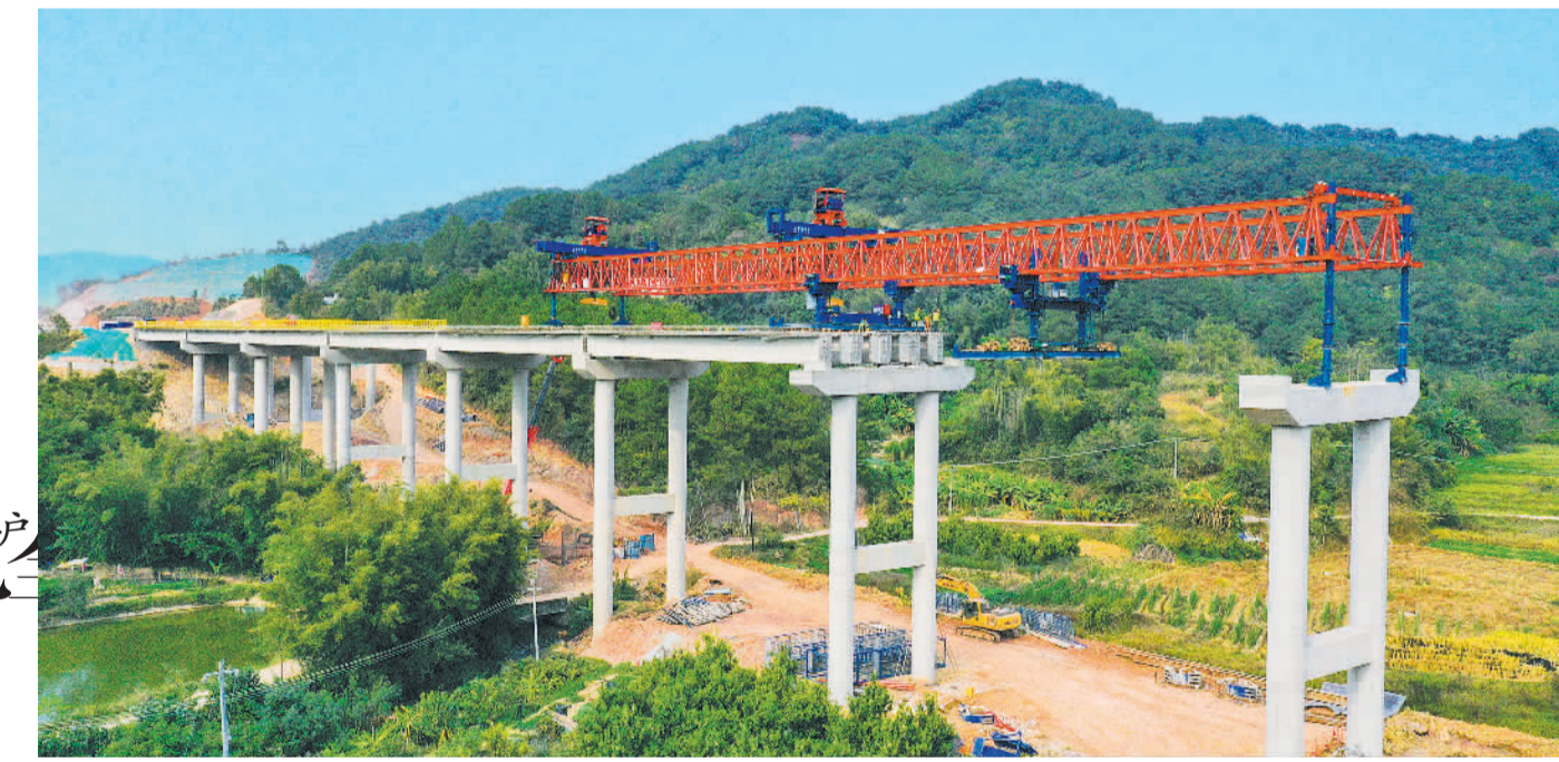
11月26日,广西梧州市藤县的平(南)岑(溪)高速公路潭水高架桥现场,工人正开展桥梁上部结构施工。平岑高速公路是广西壮族自治区及梧州市统筹推进的重大交通项目。项目建成后,可紧密联络桂东和粤西城市群,助力珠江—西江经济带发展。(颜桂海摄(中经视觉))
