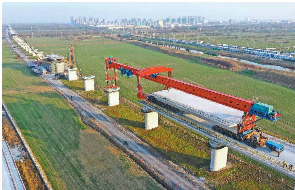
11月20日,在安徽省亳州市蒙城县阜淮铁路2标施工现场,建设者正在进行箱梁架设作业。阜淮铁路地处皖北,途经阜阳、亳州、宿州、淮北,正线全长约142.5公里。该项目建成运营后,将更好支撑长三角一体化发展。
