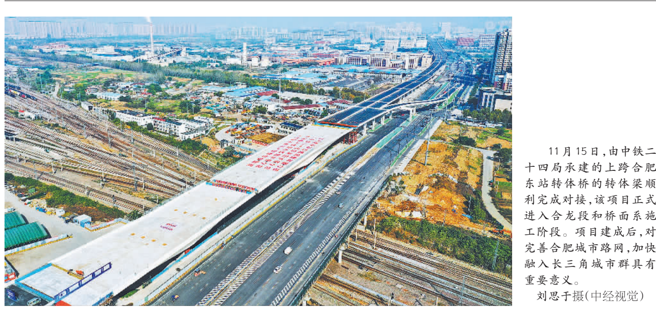
11月15日，由中铁二十四局承建的上跨合肥东站转体桥的转体梁顺利完成对接，该项目正式进入合龙段和桥面系施工阶段。项目建成后，对完善合肥城市路网，加快融入长三角城市群具有重要意义。刘思予摄(中经视觉)
