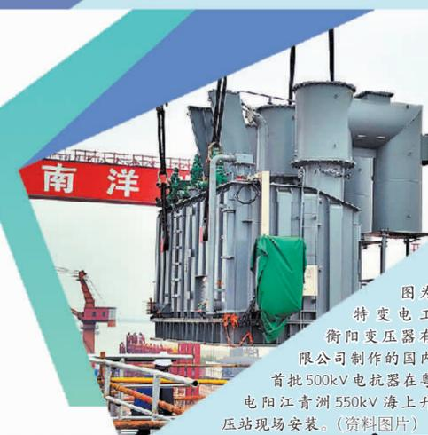
图为特变电工衡阳变压器有限公司制作的国内首批500kV电抗器在粤电阳江青洲550kV海上升压站现场安装。(资料图片)
