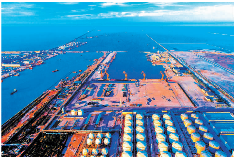
图为俯瞰山东省东营市东营港码头。近年来，东营港经济开发区通过创建“科源汇”平台，吸引了6家国内外科研机构和20余名专家入驻合作。该平台发布的石油装备新技术，解决了油田生产中的难题，推动了油田企业生产技术创新升级，为东营港高质量发展注入了新动力。
