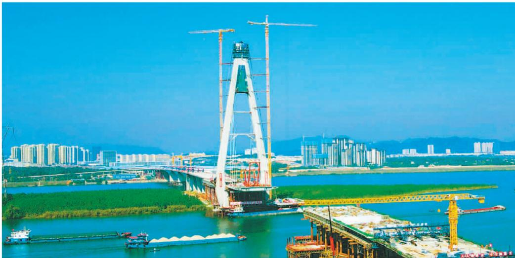
10月28日,由中交二航局承建的湖南长沙香洲大桥主塔顺利封顶。大桥主线全长约3.24公里,主塔高202米,采用“湘江之钻”造型设计,主跨300米,是湘江上跨度最大、主塔最高的独塔斜拉桥。大桥通车后,将助力长沙形成“一江两岸比翼齐飞、河东河西联动协调”的城市发展格局,对湖南省经济社会发展具有重要意义。
