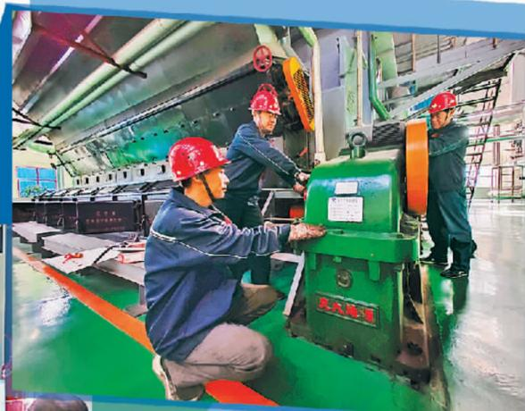
河北省石家庄市灵寿县润城供热有限公司工作人员正在检修供热锅炉减速机。白云飞摄
