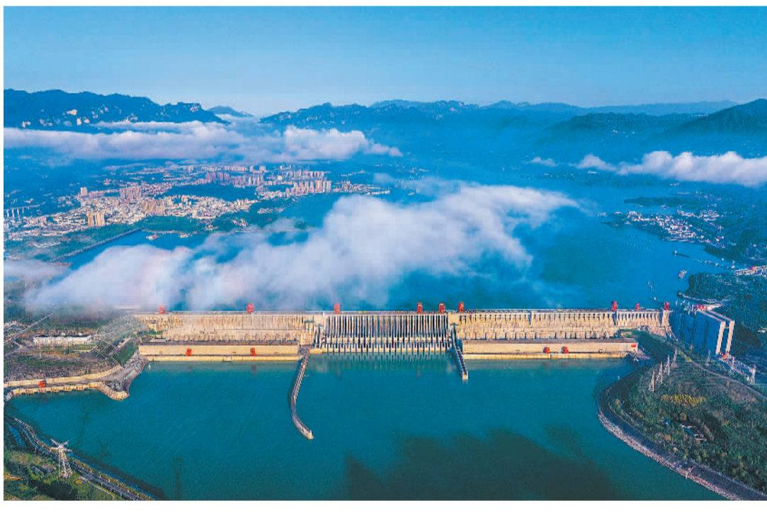
10月20日13时，三峡水库水位上涨至175米，标志着三峡水库今年满蓄目标实现。三峡水库每年汛末蓄水，枯水期至次年汛前逐渐腾出库容。截至2022年12月，三峡工程累计为长江中下游补水超过3300亿立方米。郑坤摄(中经视觉)
