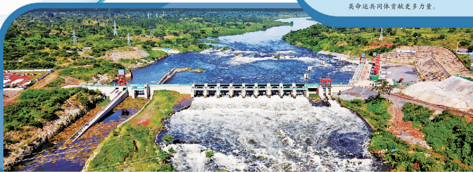
这是在乌干达基里马耶戈航拍的卡鲁玛水电站项目。
