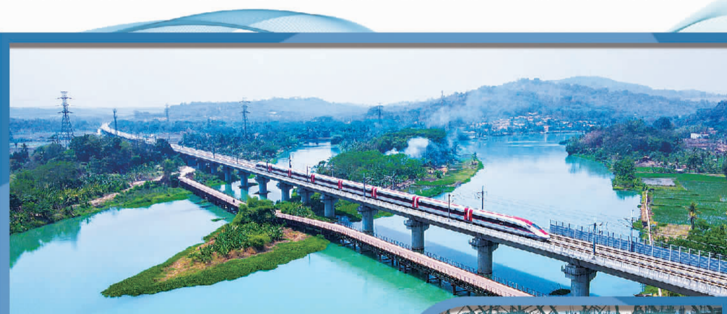
图为在印度尼西亚普哇加达拍摄的一列行驶中的雅万高铁高速动车组。新华社记者 徐钦摄
