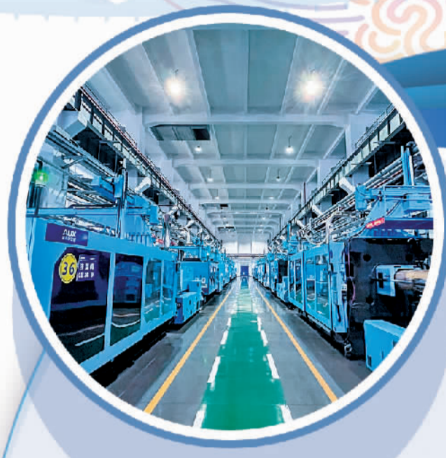
图为奥克斯空调智能化生产线。 梁齐斌摄(中经视觉)
