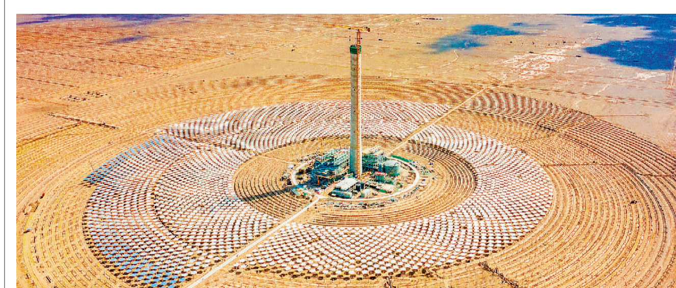
近日，在甘肃省酒泉市阿克塞哈萨克族自治县，中铁十一局承建的阿克塞东新能源光热+光伏示范项目吸热塔顺利封顶，进入设备安装阶段。该项目总体装机容量750MW，其中光热发电110MW，光伏发电640MW。项目建成后，可实现年均上网电量17亿千瓦时，加快构建酒泉新能源增长极，助推酒泉经济实现高质量发展。
