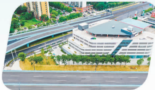
位于合肥经开区的新能源汽车充电综合体项目
