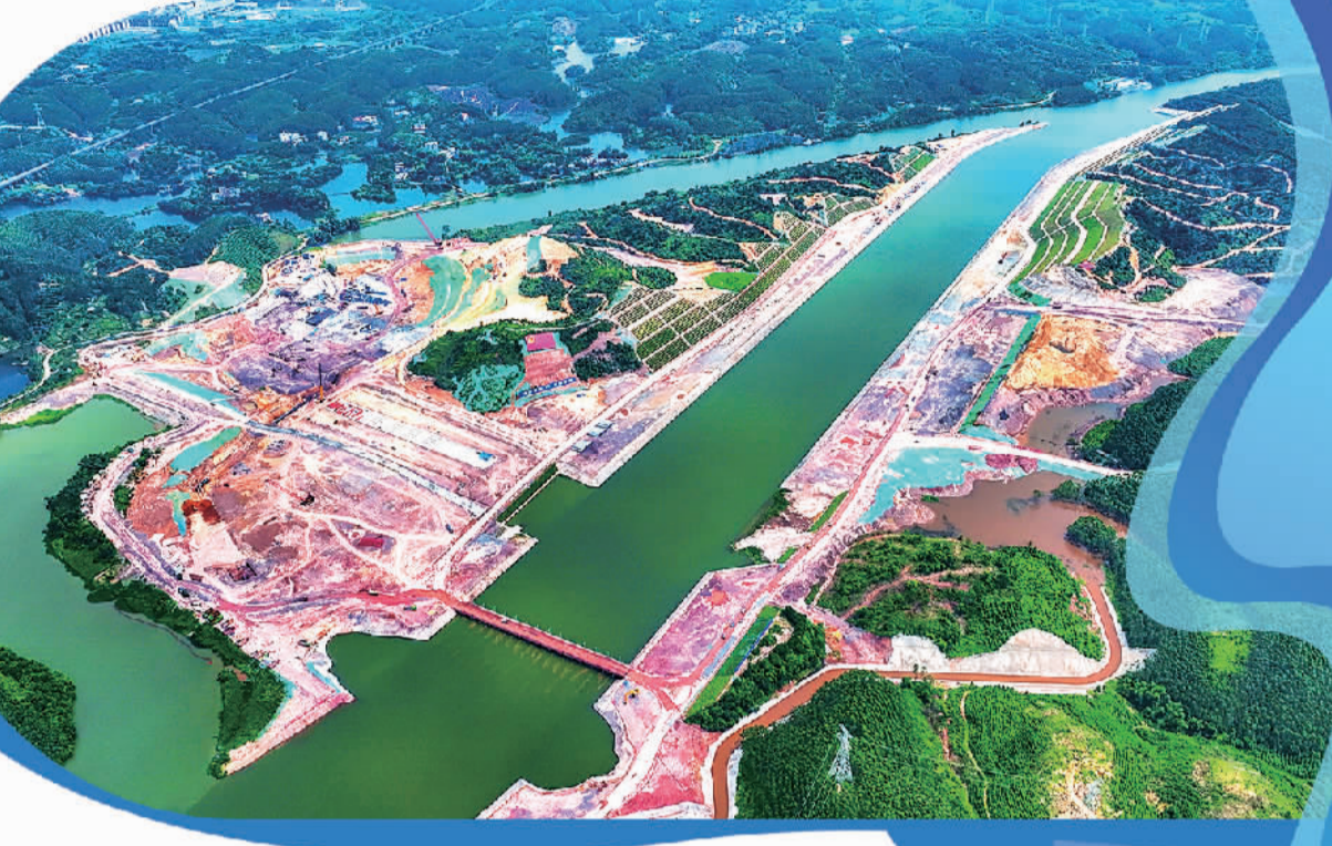
平陆运河青年枢纽施工现场。(资料图片)
