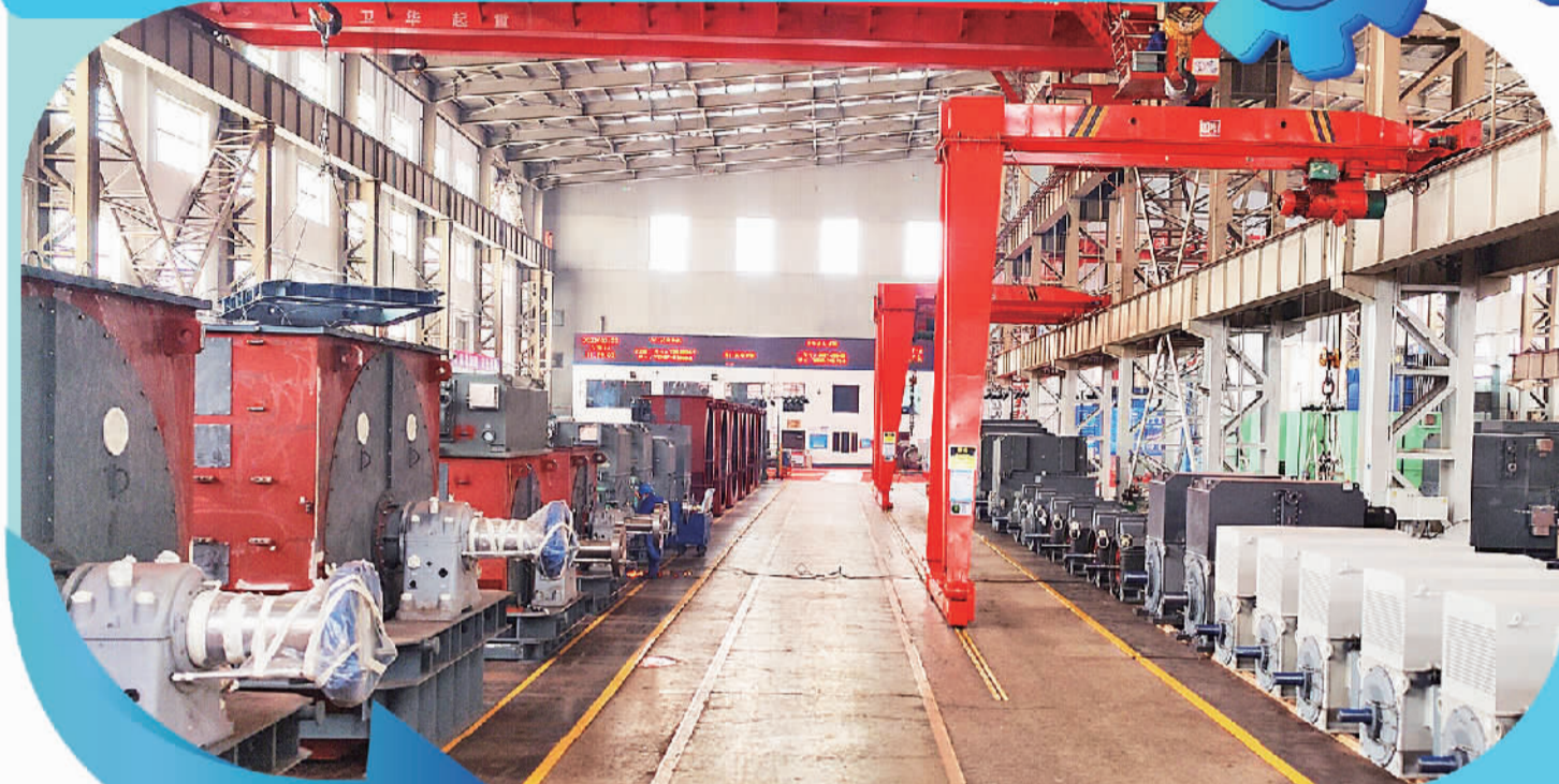
佳电股份生产车间内,自动化生产线有序运转。 本报记者 吴浩摄
