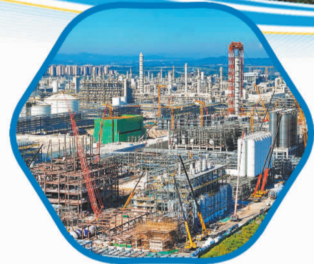
2023年8月23日,建设中的烟台化工产业园。
