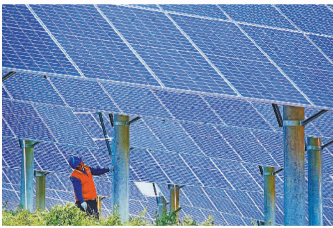
2022年9月22日,电力工人在京能国际山东烟台栖霞112兆瓦农光互补光伏电站巡检设备。
