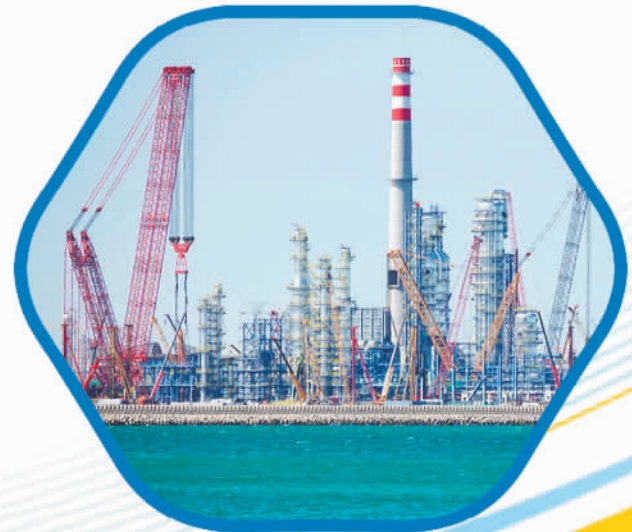
2023年4月7日,在山东烟台龙口裕龙岛炼化一体化项目建设现场,大型生产设备正在吊装。
