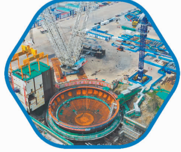
2023年7月14日,山东烟台海阳核电站4号机组岛重量最大的模块吊装就位。
