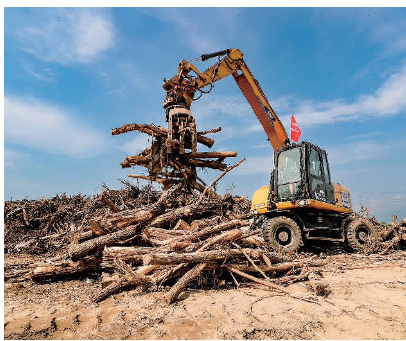
8月16日,工作人员操控机械设备进行清淤工作。受连续暴雨影响,北京市永定河河道存在大量倒伏枯死林木、垃圾、淤泥,严重污染河湖环境、阻碍河道行洪。中国铁建组织中铁二十二局等5家驻京单位,投入各类工种548人,挖掘机、推土机等各类设备193台(套),在永定河流域开展河道清理工作。
