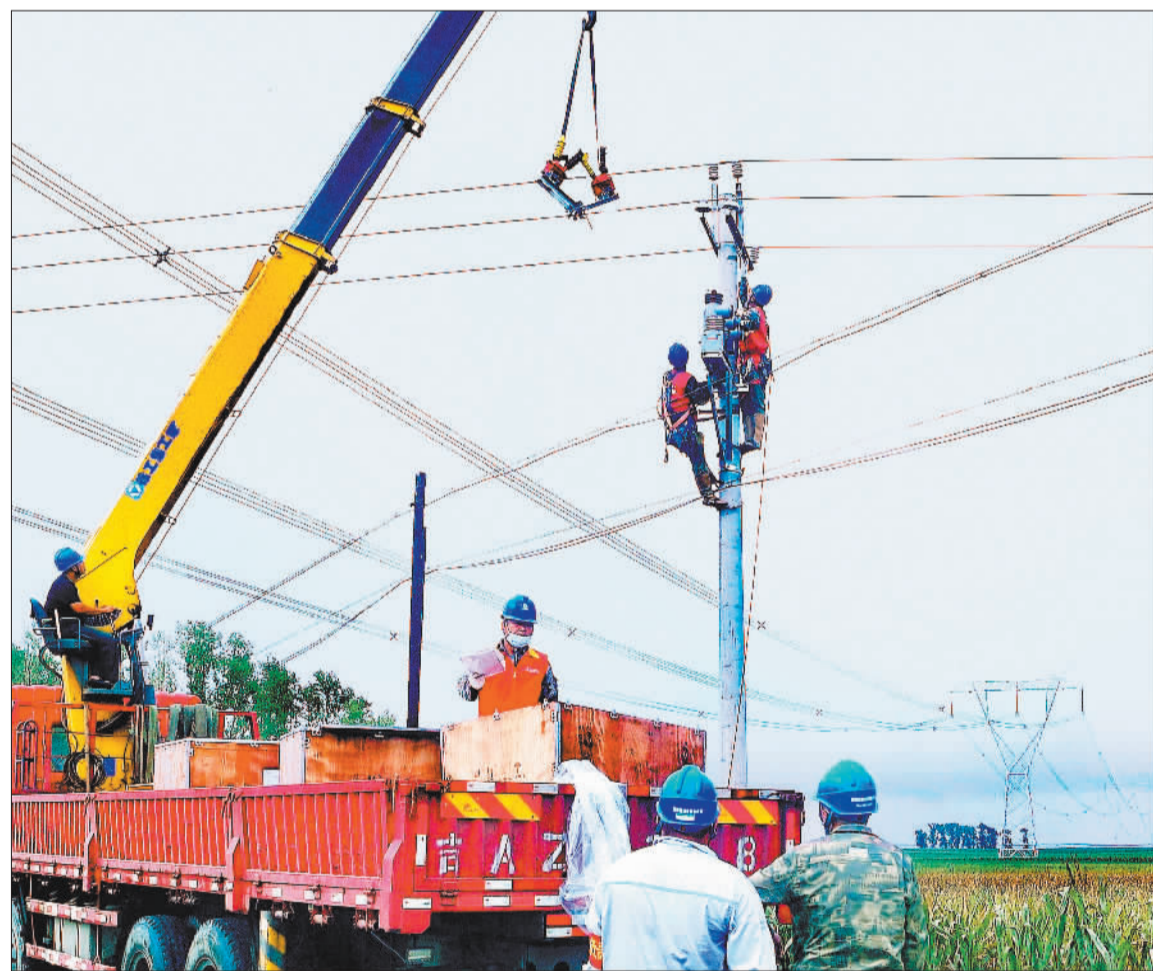
▼8月15日,国网长春供电公司工作人员在吉林省榆树市八号镇10千伏大岗线更换柱上真空开关,为当地复工复产做好供电保障。 金加强摄(中经视觉)
