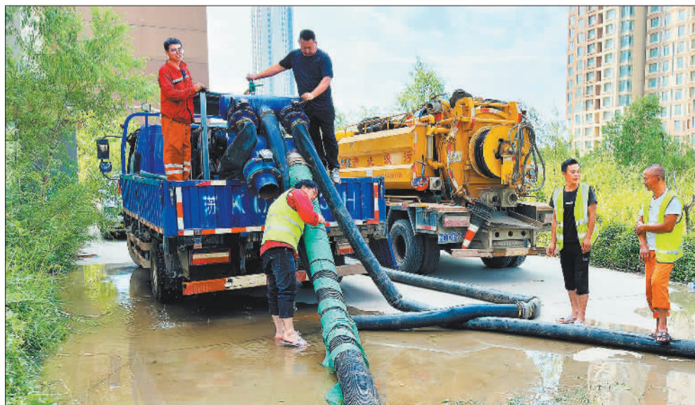
▼8月14日,河北省白沟新城执法分局救援人员在河北301后勤保障基地清理淤泥,支援灾后重建,恢复生产生活。 宋永利摄(中经视觉)
