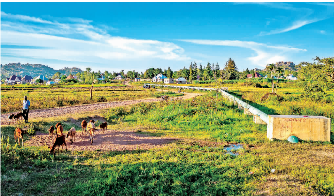
无人机照片 图为在坦桑尼亚首都达累斯萨拉姆一处沼泽地种植的水稻项目输水管道。
