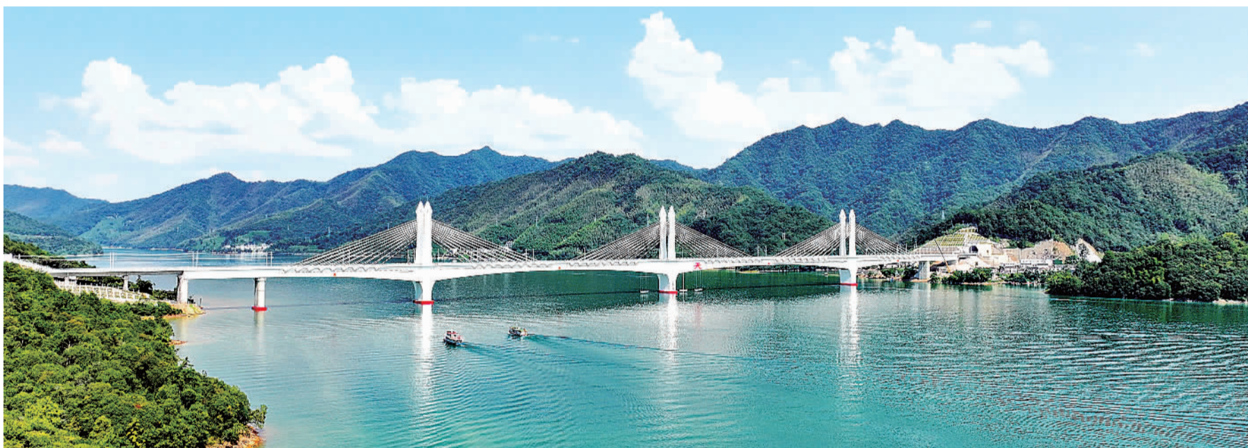
8月12日,安徽黄山,建设中的国内跨度最大的高速铁路多塔矮塔斜拉桥——池黄铁路太平湖特大桥,跃然山水之间,别具特色。池黄铁路是武汉至杭州高速铁路通道的重要组成部分,项目建成通车后,将串联皖南两山一湖(九华山、黄山、太平湖)核心景点,进一步助力当地旅游业高质量发展。张敏摄(中经视觉)
