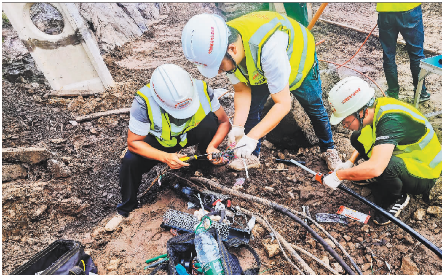
▶8月7日凌晨,中国铁建电气化局集团南方公司党员突击队在北京斜河涧站至落坡岭站区间,抢修受损的自动闭塞电缆。
