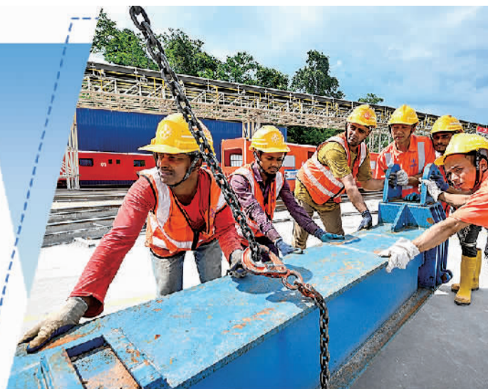
6月28日,位于中马共建“一带一路”的标志性项目——马来西亚彭亨州马东铁项目云顶隧道施工现场,几名工人合力作业。新华社记者 程一恒摄
