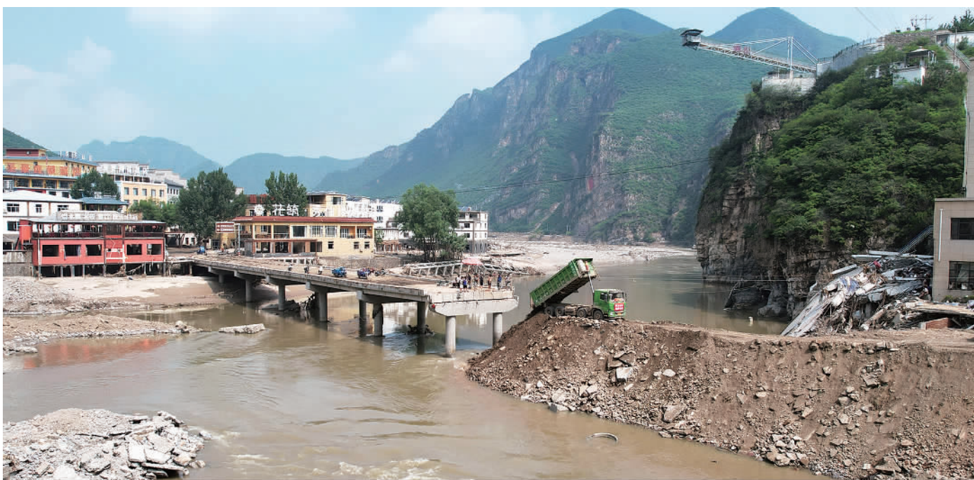
上图 8月9日,工人操作机械设备抢修通往河北省涞水县三坡镇刘家河村的桥梁(无人机照片)。新华社记者 杨世尧摄
