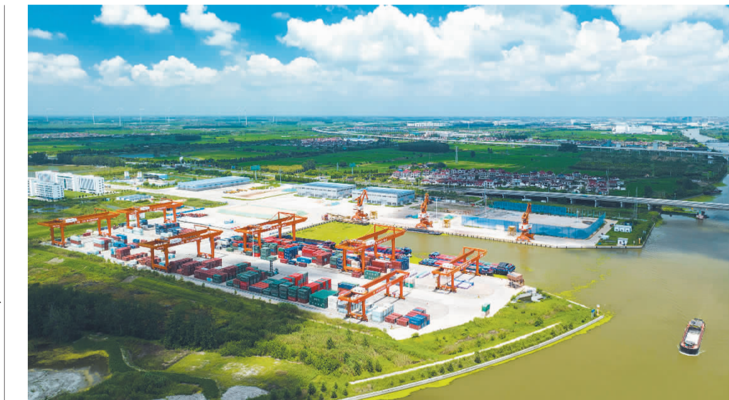
8月3日,江苏兴化港集装箱码头正紧张有序地装卸货物。近年来,兴化港创新推出“股道直装”模式,改变以往将集装箱运往指定堆场,再从堆场运输至火车股道旁的传统作业模式,减少了2次吊装作业和集卡运输环节,提升作业效率。
