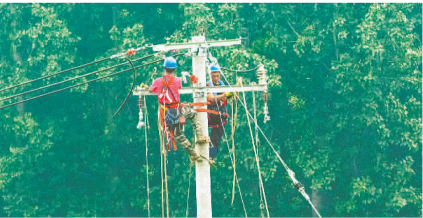
8月3日,河北省保定市易县七峪乡救援队伍在受灾地区抢修供电设施。
