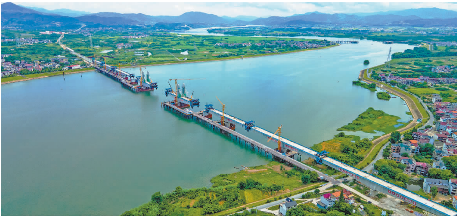
7月17日,浙江金华市兰江水域,由中铁三局承建的金建高铁兰江特大桥正进行架梁施工。该桥是金建高铁关键性控制工程,全长6538米。金建高铁是国家快速铁路网黄山至金华铁路通道的组成部分,建成后黄山至金华运行时间将缩短至1小时。胡肖飞摄(中经视觉)
