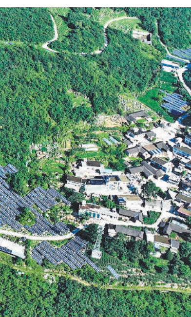
7月17日，重庆市黔江区麒麟盖山的光伏电板错落有致。近年来，黔江区利用高山地区日照时间长、风力充足的优势，建设光伏、风能等发电设施，助力构建以新能源为主体的新型电力系统，走绿色低碳发展之路。 杨敬摄 (中经视觉)
