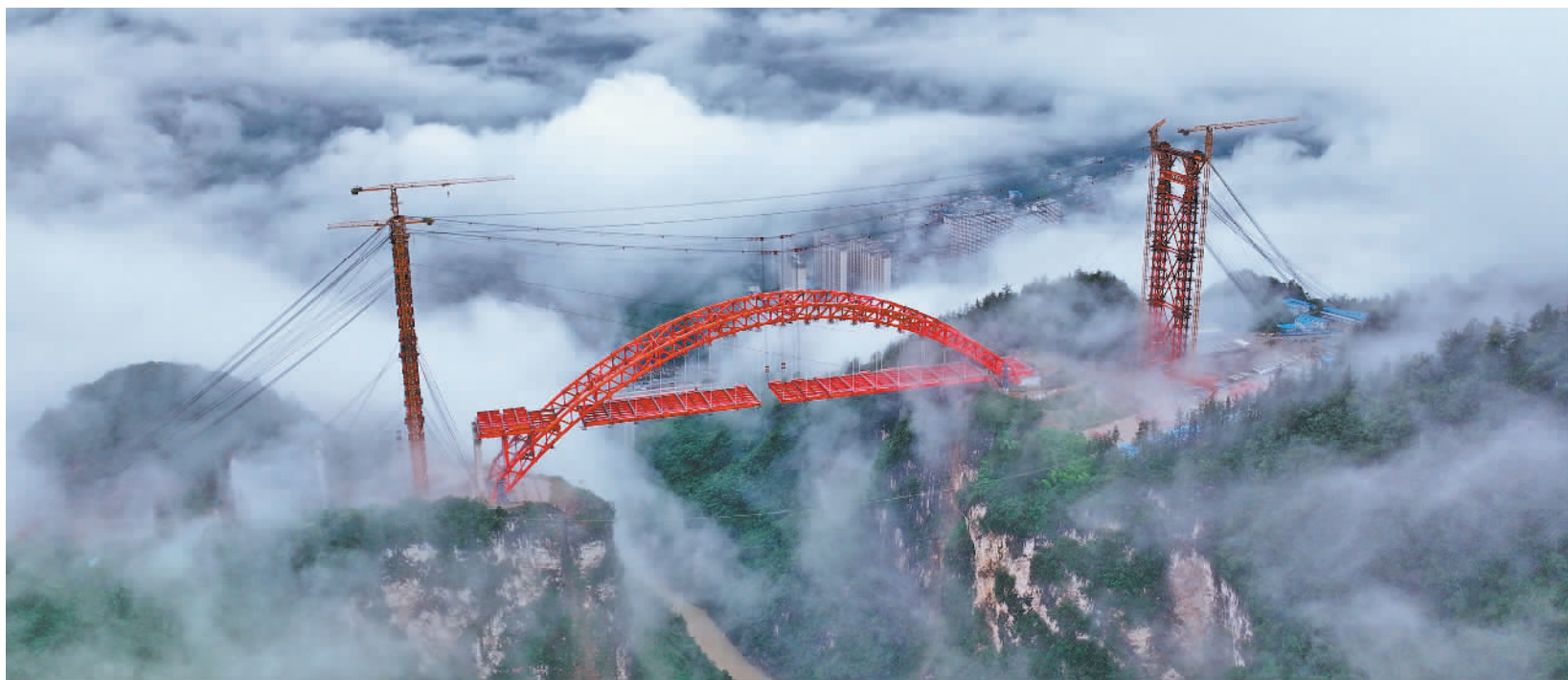
7月10日，建设中的涇水河特大桥。
