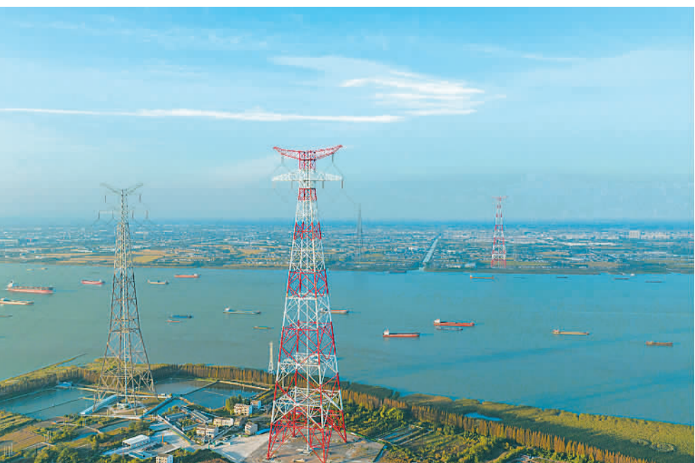
近日,国内规模最大的超高压跨越长江输变电工程——江苏泰州凤城至无锡梅里500千伏输变电工程正式建成投运,预计最大年送电量超过260亿千瓦时,相当于一个中等城市一年的用电量,为长三角地区夏季电力供应提供坚强保障。董小强摄(中经视觉)
