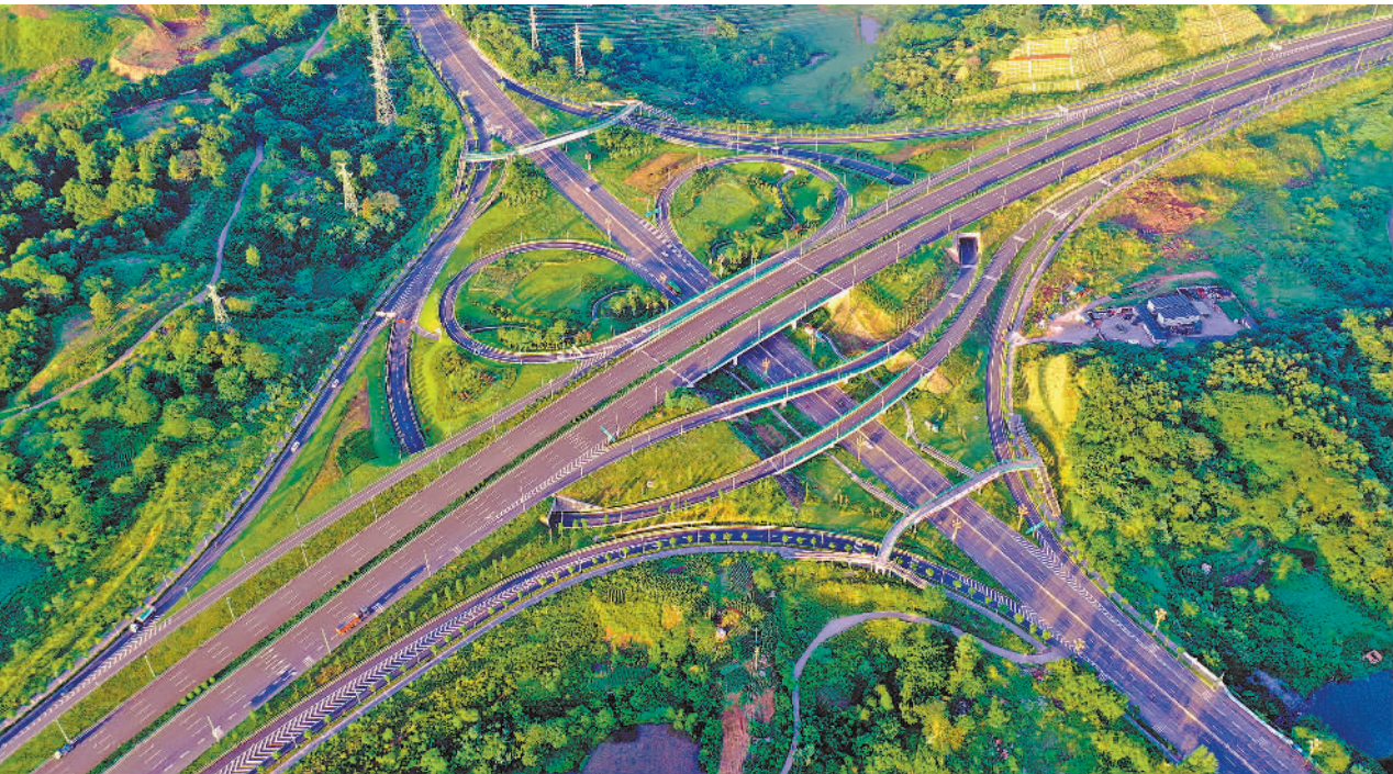
7月5日,航拍四川省泸州二环路纳溪段蓝安立交。近年来,当地着力构建水陆联动的立体交通网络新格局,纳溪长江大桥、石龙岩码头等交通项目快速推进,服务区域经济高质量发展。
