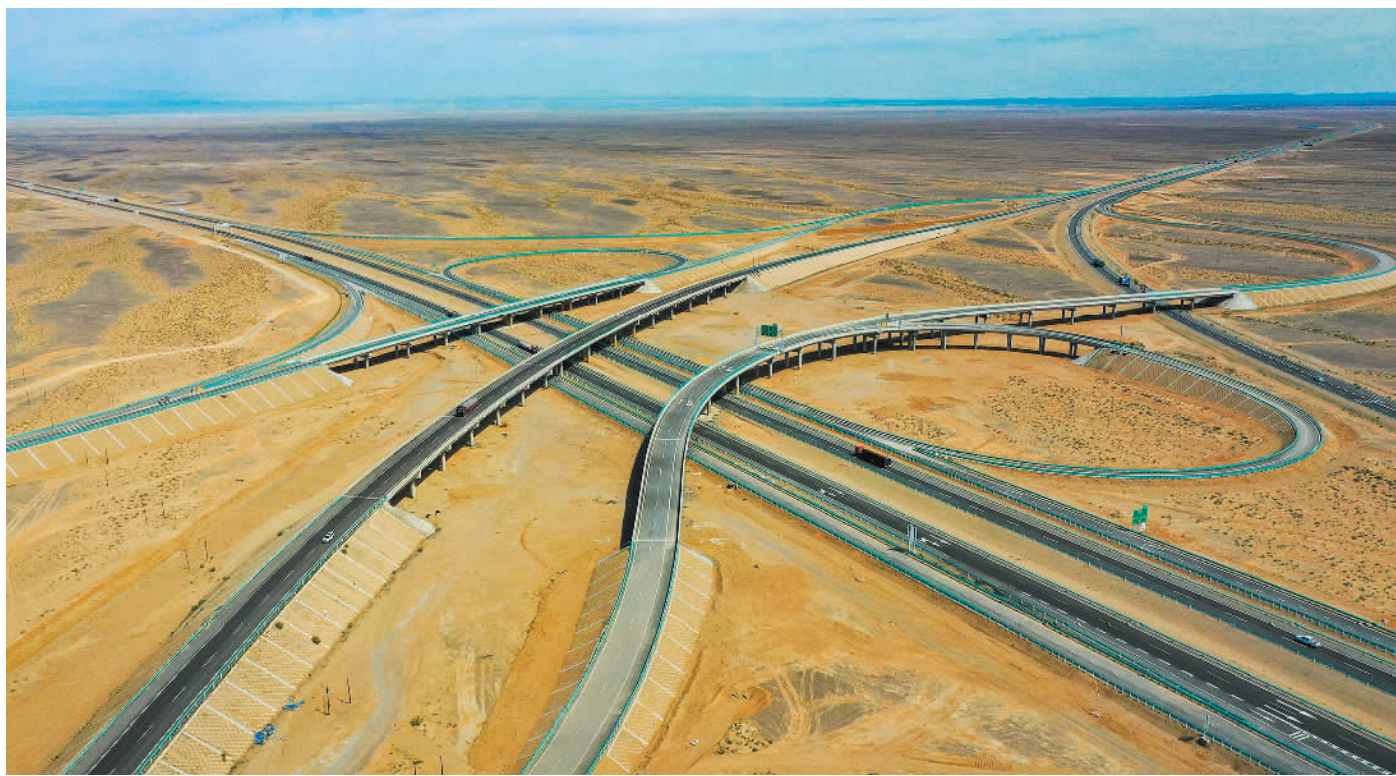
6月29日,新疆S519梧桐泉—沙泉子高速公路全线通车,标志着G7京新高速与G30连霍高速两条进出疆主要通道实现有机连接。项目建成后,哈密东部和北部区域多条公路形成环线快速运输通道,对改善区域交通运输能力具有重要意义。普拉提·尼亚孜摄(中经视觉)
