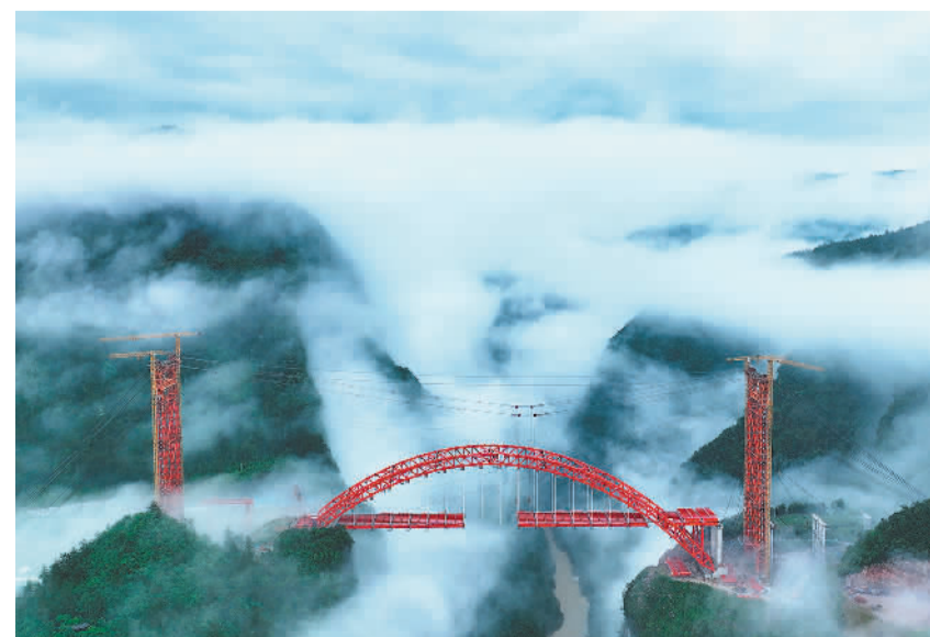
因为建设中的溇水河特大桥。据悉，溇水河特大桥位于湖北省恩施土家族苗族自治州鹤峰县，是宜来高速公路鹤峰东段的控制性工程。宜来高速公路建成后将进一步完善鄂湘渝毗邻区路网结构。杨顺丞摄(中经视觉)
