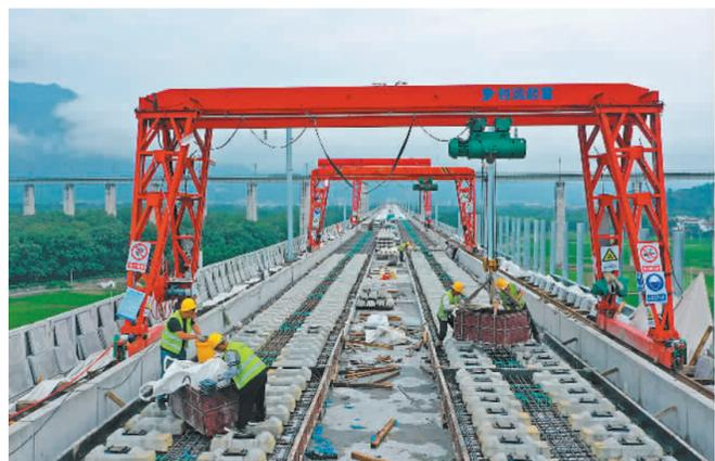
6月22日,在杭温铁路浙江省台州市仙居永安溪特大桥施工现场,工人在无砟轨道施工。为确保项目按期完工,铁路建设者端午假期坚守岗位,加班加点赶进度。王华斌摄(中经视觉)
