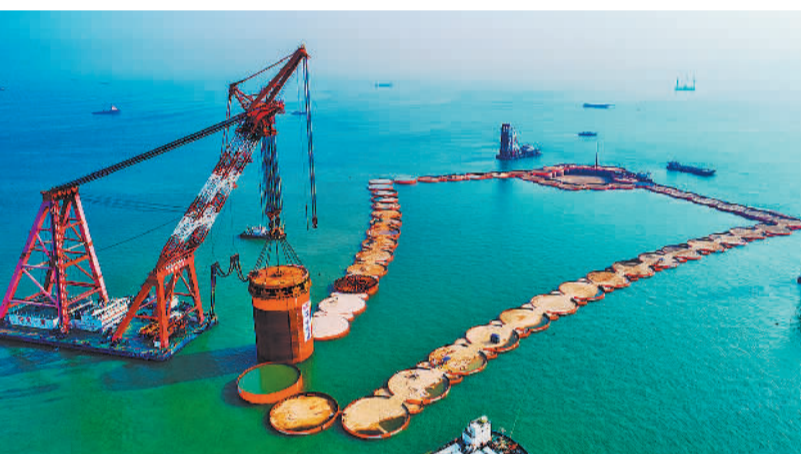
图为深中通道西人工岛最后一个钢圆筒吊装。
