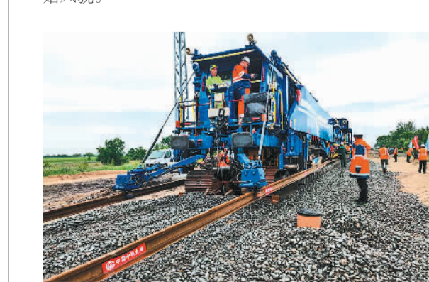
匈塞铁路(匈牙利段)铺轨施工现场。本报记者 翟朝辉摄
