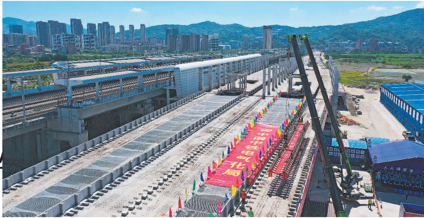
6月1日,在福建省福州滨海快线首占铺轨基地,作业人员操作起重机械将首节25米轨排铺设在首占西高架上,标志着由中国中铁电气化局集团有限公司承建的福州滨海快线正式开始轨道施工。福州滨海快线建成通车后,可实现市中心至滨海新城30分钟内通达,福州火车站至机场40分钟通达,助力实现闽东北协同发展区中心城区1小时交通圈。丁玲摄(中经视觉)
