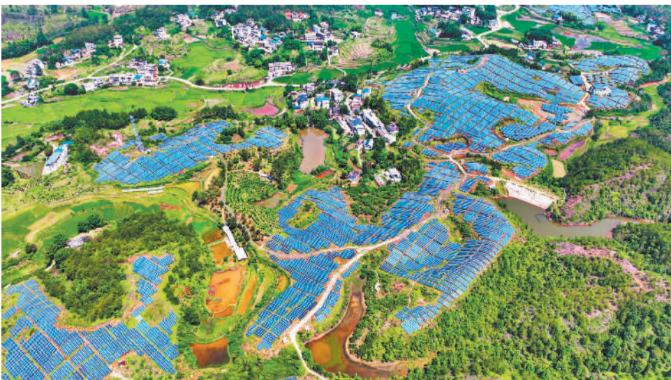
日前，江西省赣州市会昌县庄口镇黄沙村，蓝色的光伏发电板依次排布。近年来，会昌县利用荒山、废弃矿场、厂房屋顶等区域进行集中式和分布式清洁能源深度开发，加快推进光伏发电项目落地，带动群众增收致富。朱海鹏摄(中经视觉)
