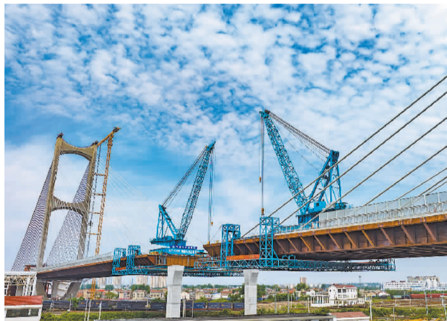
5月23日,湖北襄阳中铁十一局襄北编组站大桥施工现场,工人正在进行钢梁悬拼作业,全力冲刺大桥合龙。襄北编组站大桥为双塔双索面混合梁斜拉桥,主桥长920米,建成后将有缓解当地道路交通压力。金伟摄(中经视觉)
