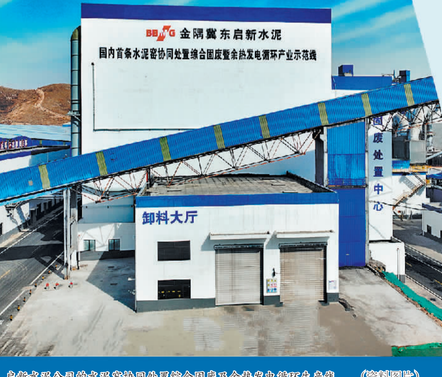
启新水泥公司的水泥窑协同处置综合固废及余热发电循环生产线。(资料图片)
