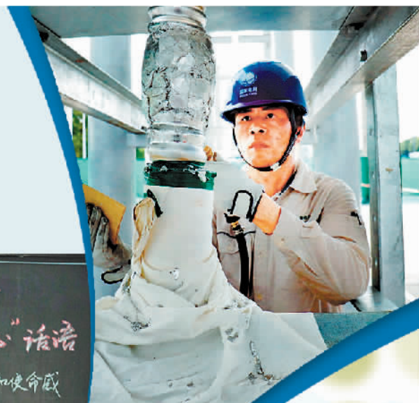
赵斌在进行超高压电缆接头打磨作业。(资料图片)
