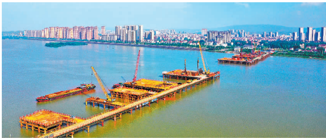
5月18日，江西省吉安市泰和县赣江东门渡口处，渡改桥项目澄江大桥工程正在加紧施工。大桥建成后，将改善两岸群众出行条件，助力当地经济社会发展。邓和平摄(中经视觉)
