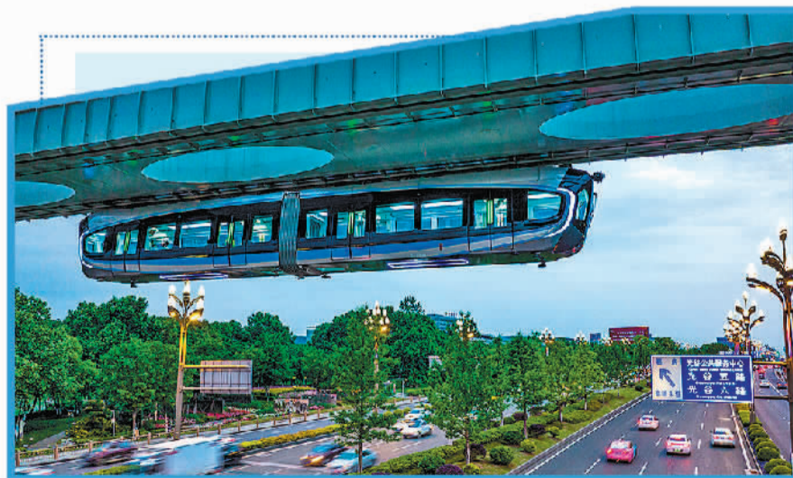
5月11日，国内首条悬挂式空中轨道列车——“光谷光子号”在武汉试乘开跑。肖艺九摄（中经视觉）
