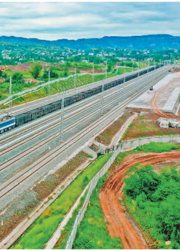
5月9日，重庆市万盛经开区关坝铁路专用线项目顺利完成4500吨列车牵引试验，标志着该项目全线已具备通车条件。
