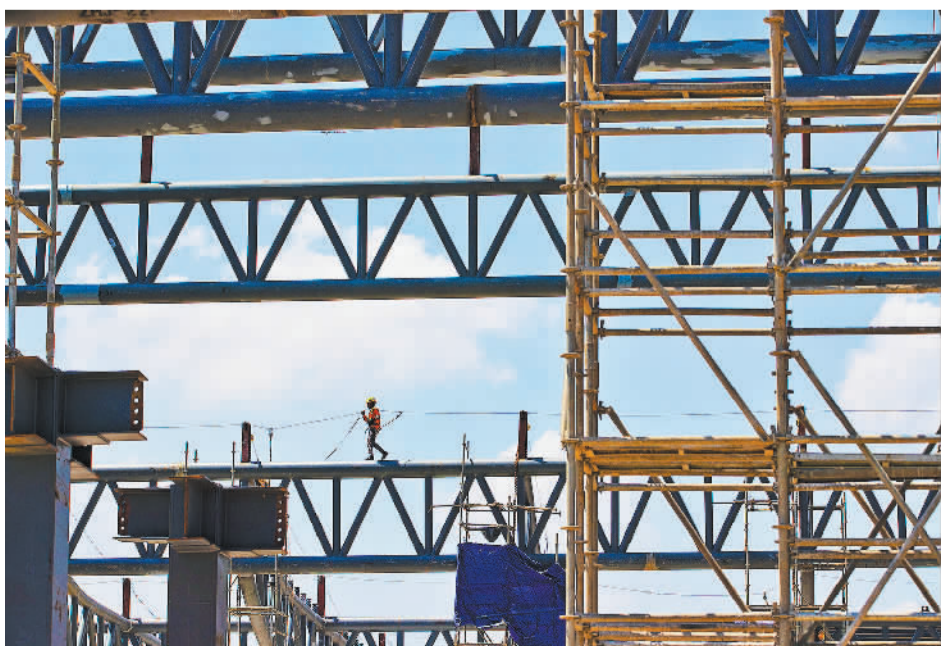
建设中的雅万高铁帕达拉朗车站。
