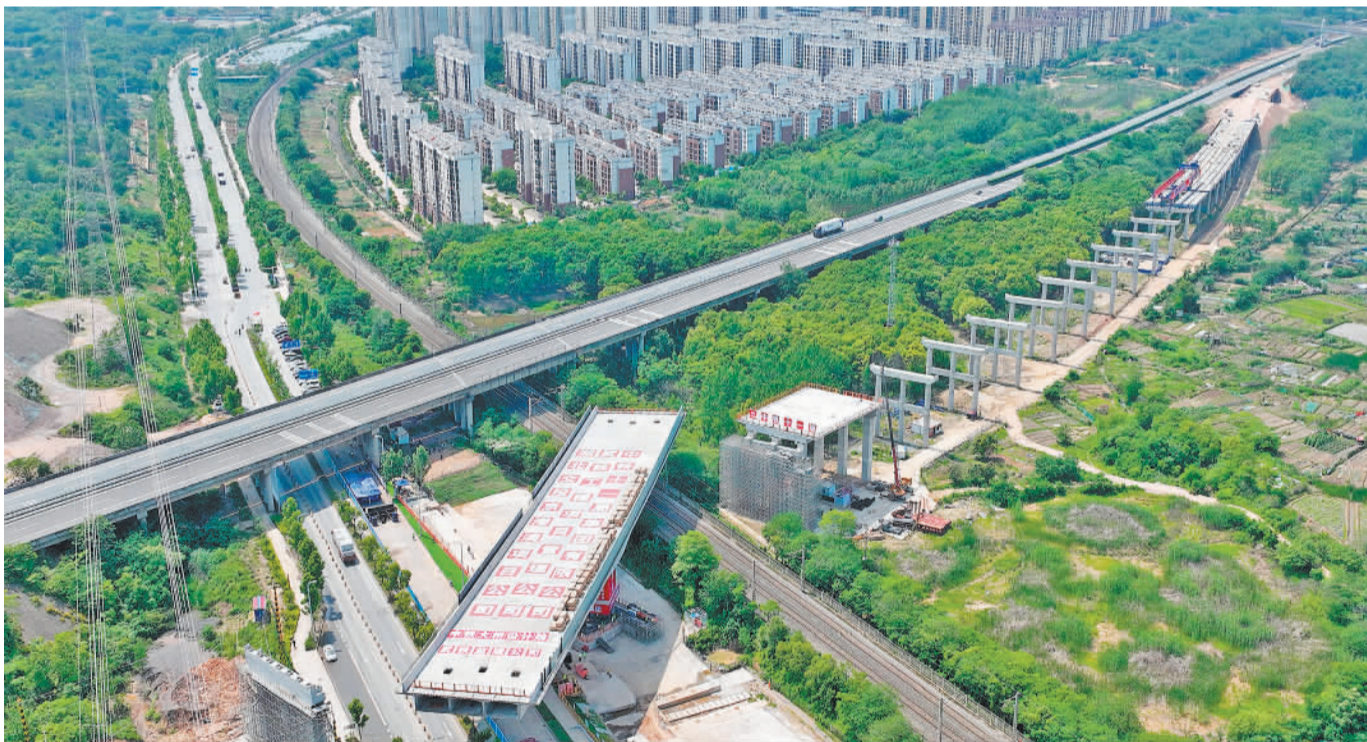
5月9日，转体重量14000余吨的武汉绕城高速改扩建转体桥成功转体，在100分钟内顺时针旋转71度，跨越武九铁路和森林大道公路大动脉。
