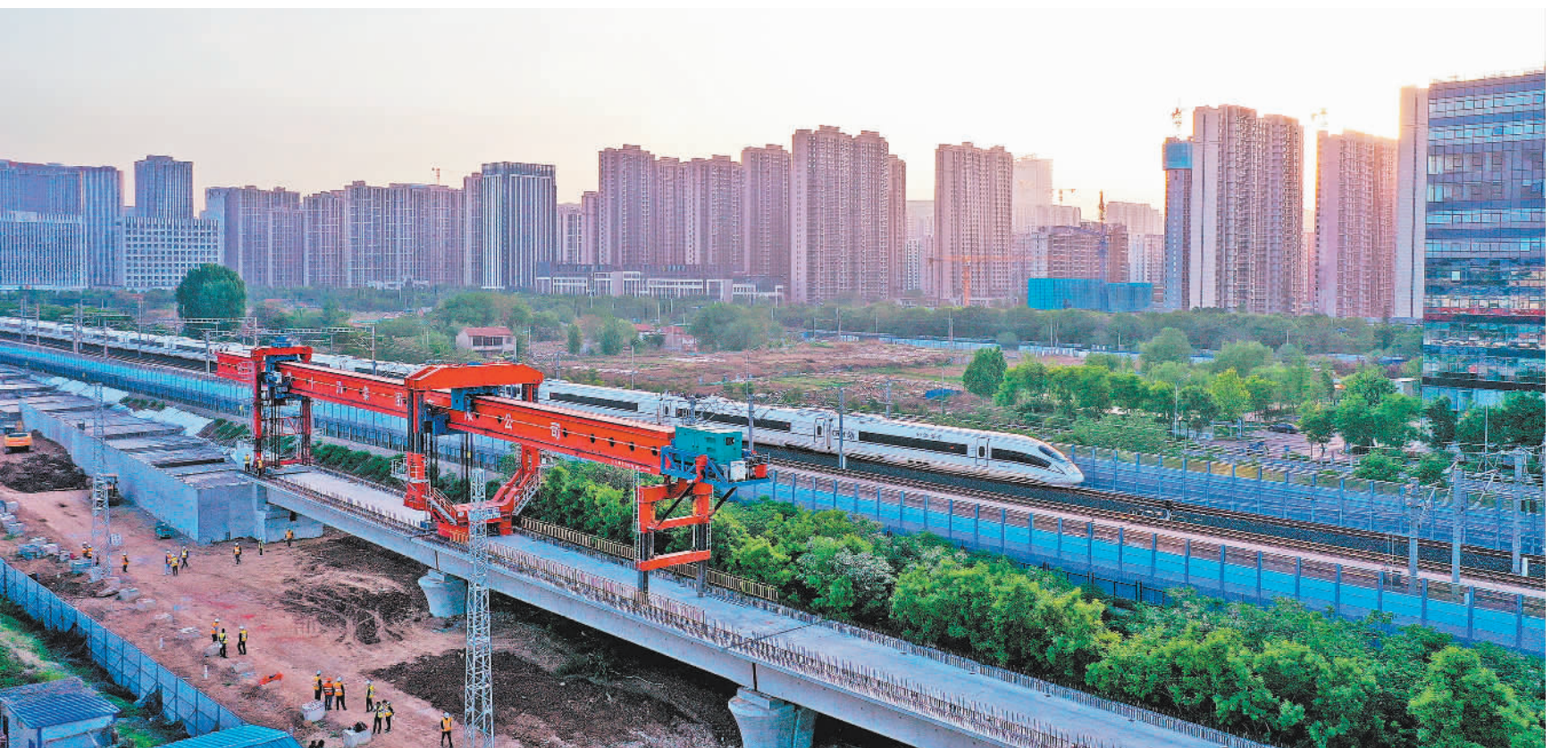
5月7日,济(南)郑(州)高铁山东段最后一根箱梁在中铁十局站前1标顺利架设完成,至此,济郑高铁山东段完成全部箱梁架设工作,全面转入铺轨阶段。济郑高铁是国家“八纵八横”高铁网重要组成部分。项目通车后,济南到郑州的通行时间将缩短至1.5小时。
