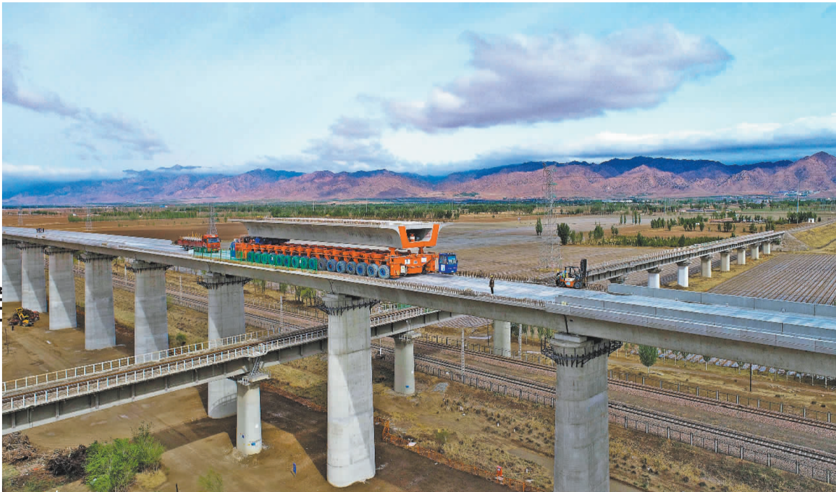
5月5日拍摄的包(头)银(川)高铁跨万甘铁路特大桥箱梁架设施工现场。当日,由中铁上海工程局承建的包银高铁跨万甘铁路特大桥箱梁架设任务完成,标志着包银高铁内蒙古段首座跨铁路特大桥主体工程全部结束。包银高铁是我国“八纵八横”高速铁路网京兰通道的重要组成部分,设计时速250公里,计划2025年建成通车。
