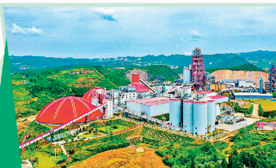
贵州省铜仁市玉屏侗族自治县田坪镇一家水泥企业的智能化生产车间。 胡攀学摄(中经视觉)
