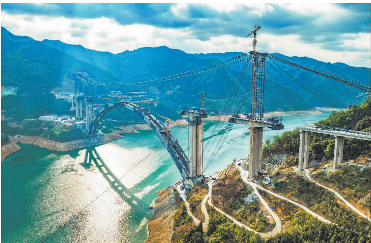
5月3日，广西河池市南丹至天峨下老高速公路天峨龙滩特大桥建设不停歇，工人们赶时间、抢进度，力争实现年底建成通车目标。大桥横跨广西红水河，全长2488.55米，是国家交通运输行业重点科技项目。 周恩军摄(中经视觉)
