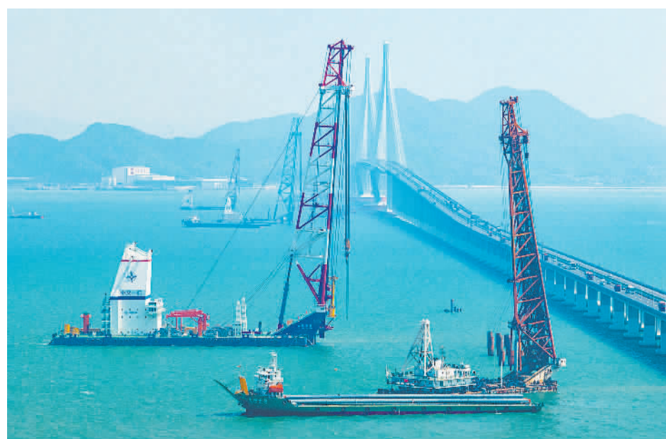
近日,在浙江省宁波至象山海域(郊)铁路工程象山港跨海大桥项目海上施工现场,多艘打桩船同步作业。该大桥是国内首座海域(郊)铁路跨海大桥,全长约61.45公里。
